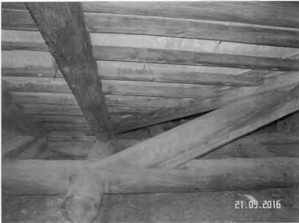
Фото 16. Узлы соединения стропильных конструкций.
